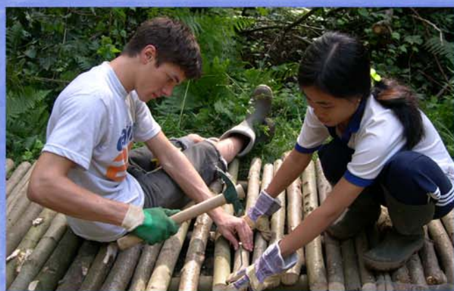
Chantier de la Source des fées, Saint Forget, Yvelines, France
